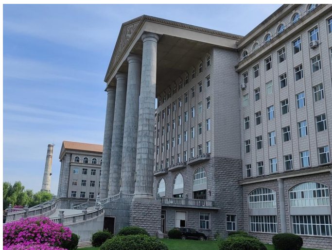
Photo 2.2. Bâtiment principal de l'université agricole de Jilin, où s'est tenue l'ASPT5. Les colonnes d'un bâtiment de 7 étages mesurent environ 30 m de haut, et j'ai appris que ces colonnes de granit pèsent 100 tonnes chacune.
