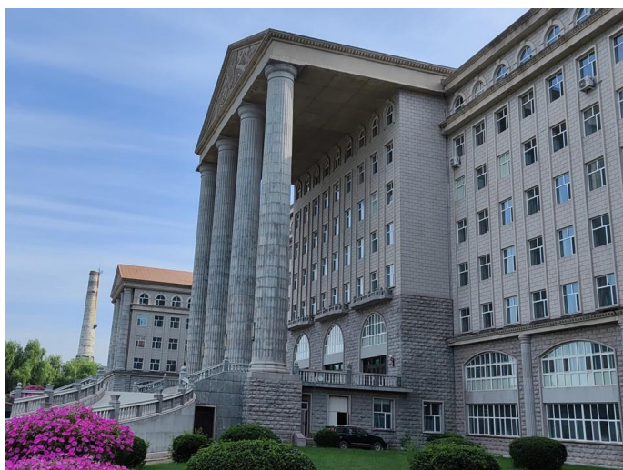
Figura 2.2. L'edificio principale dell'Università Agraria di Jilin, dove si è tenuto l'ASPT5. Le colonne di un edificio di 7 piani sono alte circa 30 metri e mi hanno informato che queste colonne di granito pesano 100 tonnellate ciascuna.
