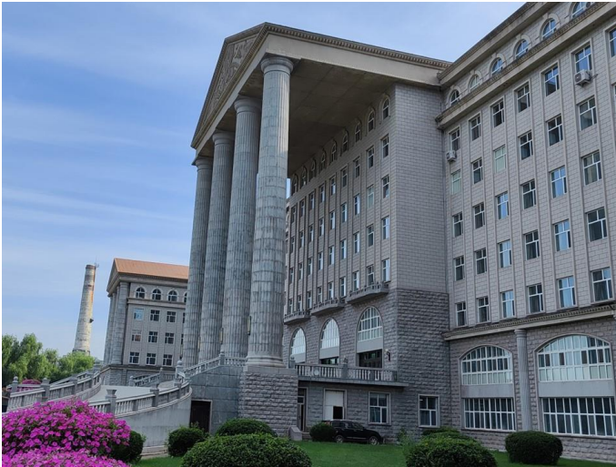
Resim 2.2. ASPT5'in yapıldığı yer olan Jilin Tarım Üniversitesi'nin ana binası. 7 katlı binanın kolonları yaklaşık 30 m yüksekliğinde ve bana bu granit kolonların her birinin 100 ton ağırlığında olduğu söylendi.
